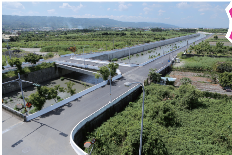
▲ 員林大排上游於8月完成整治後，有效改善防洪和交通。
