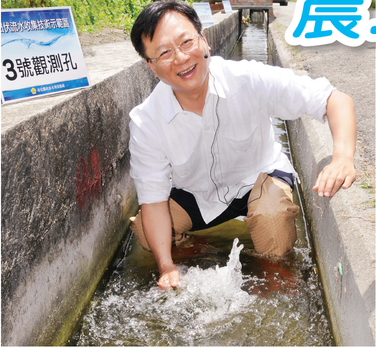
拔開觀測孔蓋，伏流水汨汨流進灌溉溝，卓縣長看到彰化成功開發出全國首創的新水源，當場樂開懷。
